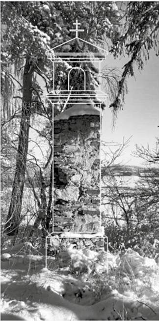
Stávající stav kapličky na pozemku parc. č. 844
